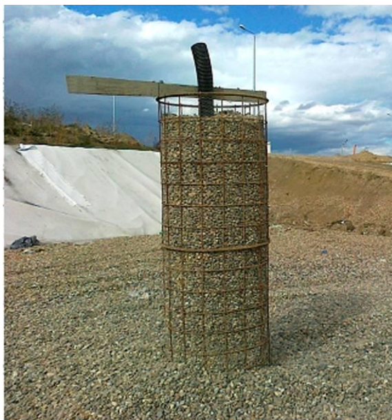
Слика 4.4 Изглед једног вентилационог бунара (биотрна)
